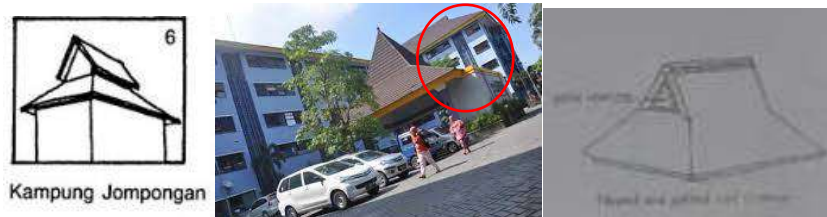
Gambar 2. 34 Atap Kampung Jompongan pada Rusun Gunungsari
