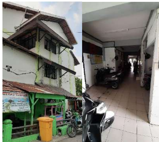
Gambar 2. 23 Kios dan Parkir Motor Rusunawa Dupak Bangunrejo
