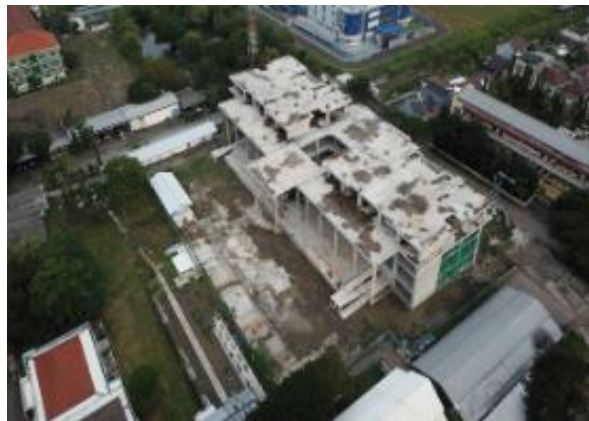
Gambar 1.2 Kondisi Proyek Sumber : Dokumentasi Proyek
