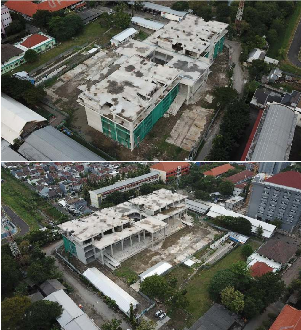
Gambar 1.2 Kondisi Proyek Pada Minggu-14
