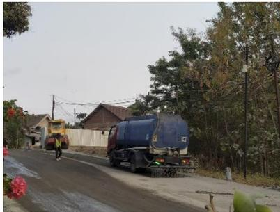
Gambar 8.12 Penyiraman Agregat Dengan Tangki Air
