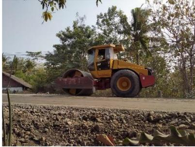
Gambar 8.11 Pemadatan Agregat Menggunakan Vibro Roller
