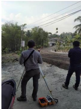
Gambar 8.7 Pengukuran Elevasi Menggunakan Waterpass
