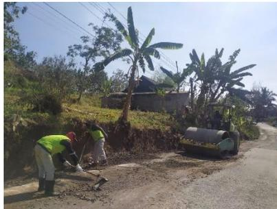
Gambar 8.5 Pemadatan Agregat
