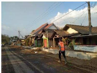
Gambar 9.2 Sisa galian tanah yang digunakan untuk pengurugan u-ditch
