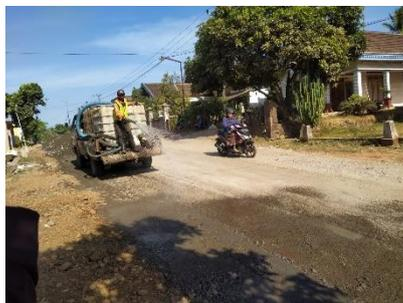
Gambar 8.6 Penyiraman Agregat
