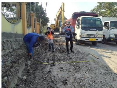
Gambar 8.1 Pengukuran Lebar Bahu Jalan
