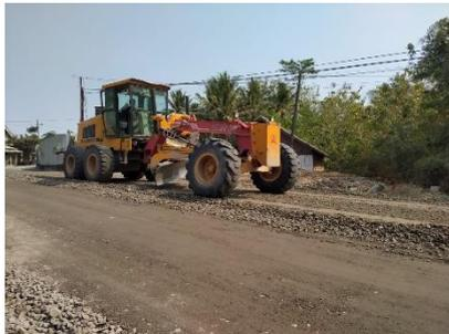
Gambar 8.10 Perataan Agregat Menggunakan Grader
