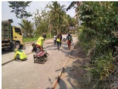
Gambar 9.4 Pemasangan bekisting
