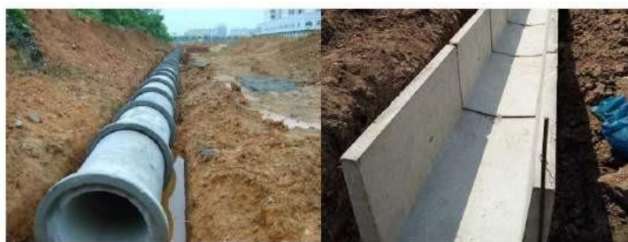
Gambar 1 Saluran Terbuka dan Tertutup
