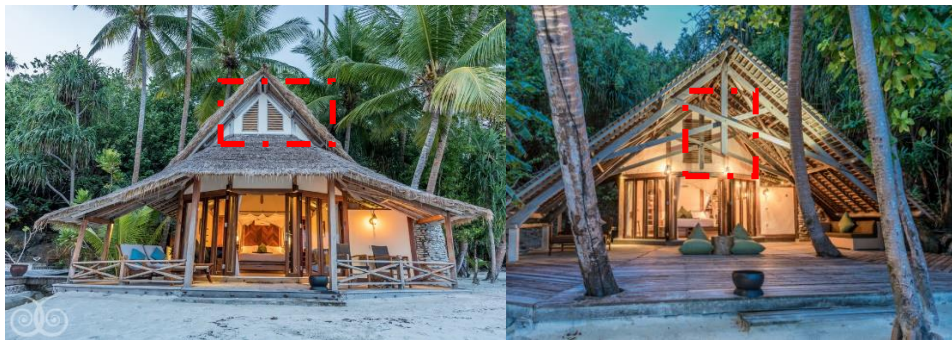
Gambar 2.40 jalusi kayu pada Misool Eco Resort Sumber gambar: misool.info
