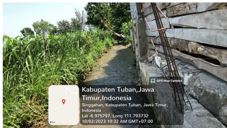
Gambar 1.2 Kondisi sekitar desa Tingkis Sumber : Dokumentasi Pribadi
