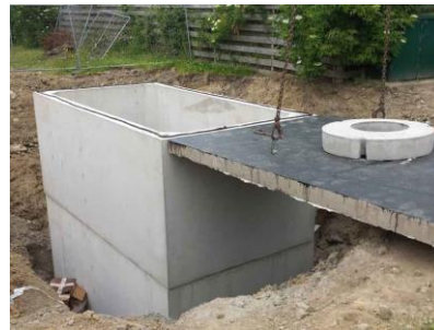
Gambar 2. 23 Tangki reservoir dari beton
