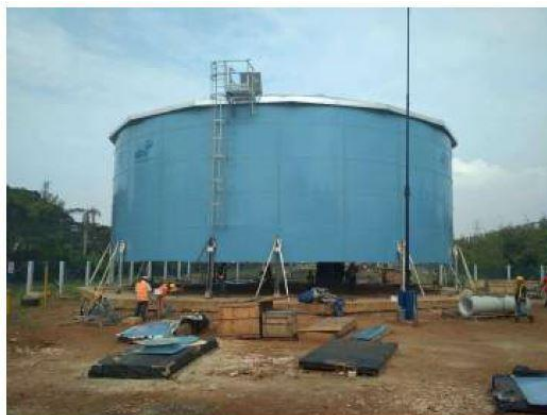
Gambar 2. 23 Reservoar Tangki Baja
