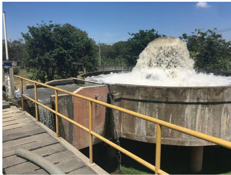
Gambar 2. 6 Bangunan Aerasi
