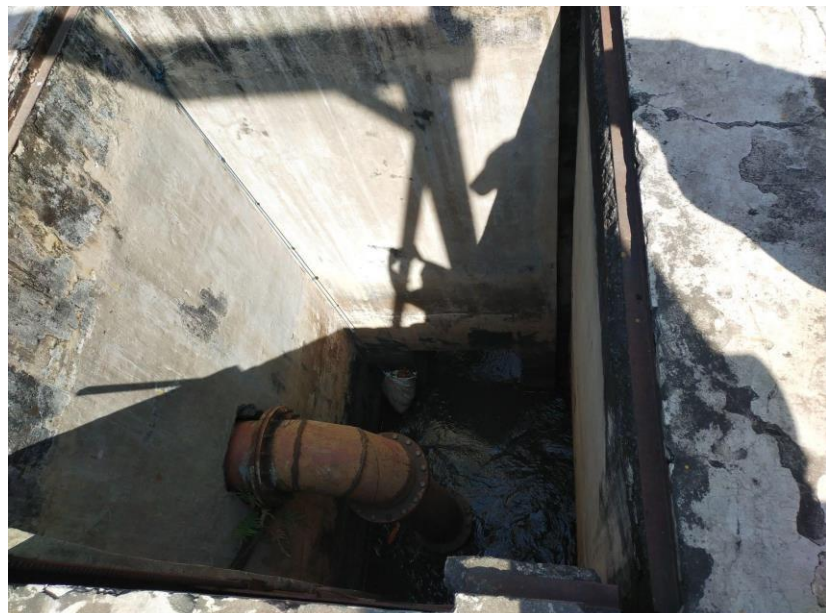
Gambar 2. 4 Bangunan Sumur Pengumpul
