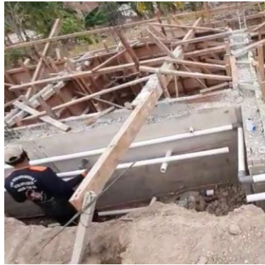
Gambar 2.1 Proses pembuatan sauran air kotor(kiri), dan Proses pengecoran plat lantai (kanan)
