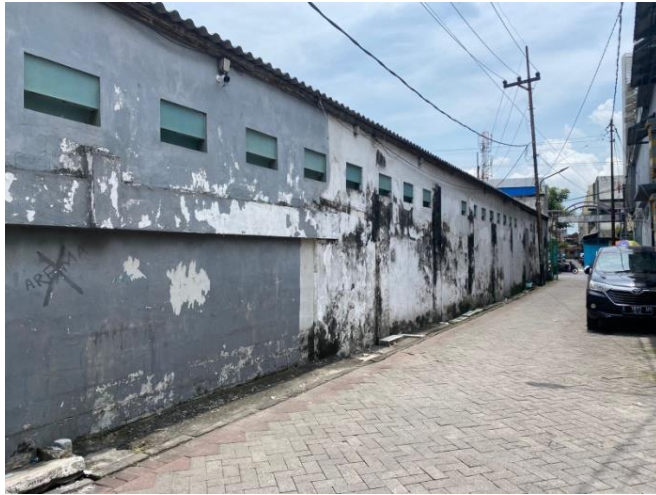
Gambar 2.1. 1 Dinding Menuju RW 8
