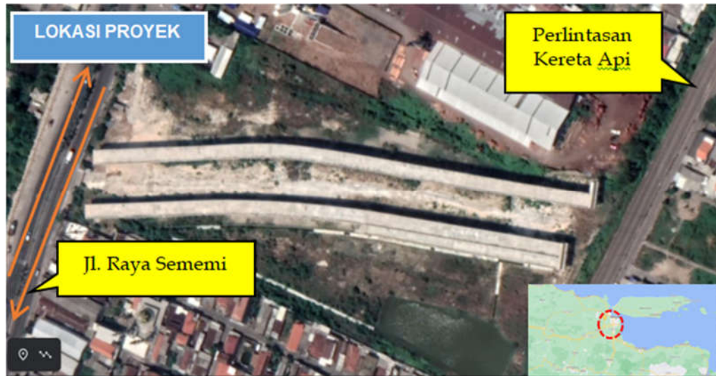
Gambar 1. 1 Lokasi Proyek Pembangunan Jalan Flexible Pavement Kolektor Type 2 JL. JLLB (Sememi ke Utara) (Sumber: Google Earth)
