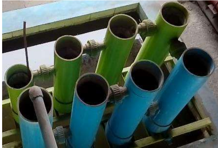
Gambar 5.8 Tabung Filtrasi & bak penampung akhir
