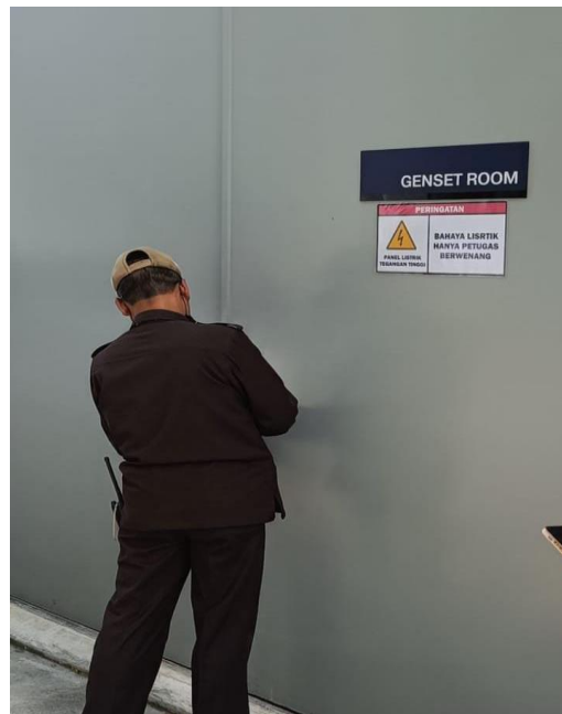
Gambar 2.8 Pelaksanaan penempelan tanda ruangan terbatas pada ruang Genset
