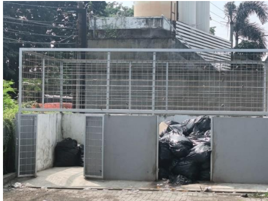
Observasi TPS kawasan kantor Pelindo Place Tower untuk digunakan sebagai data pada laporan magang
