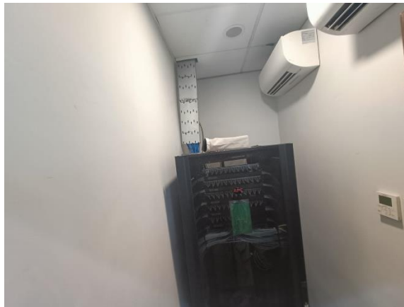
Inspeksi Ruang Server
