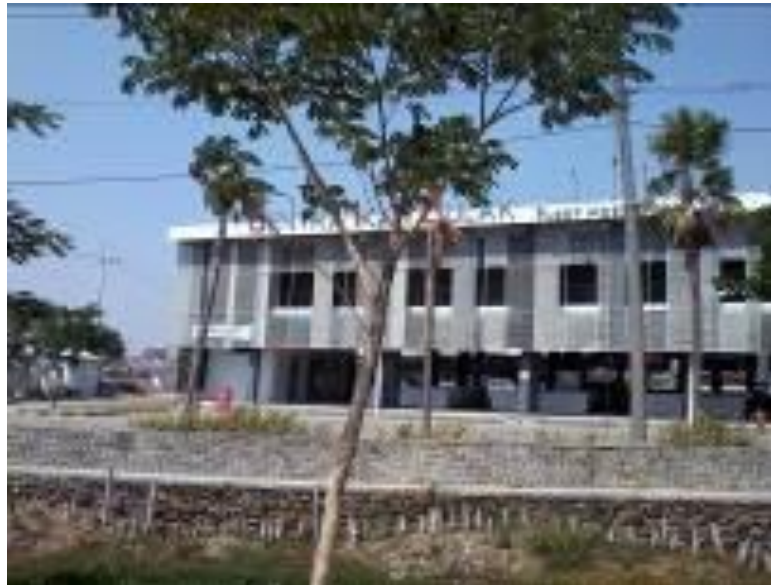
Gambar 4. Kondisi Bangunan Pusat Pengolahan Ikan Bulak
