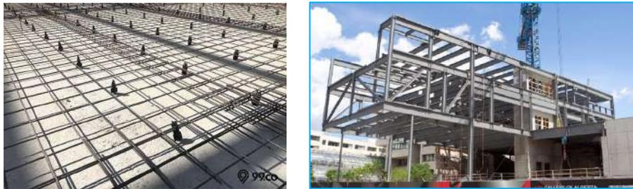
Gambar 5.4 Contoh Struktur Rangka Baja dan Plat lantai
