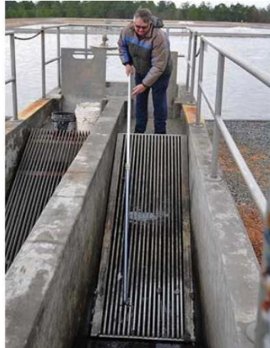
Gambar 5 Pembersihan Bar Screen Manual di Lapangan
