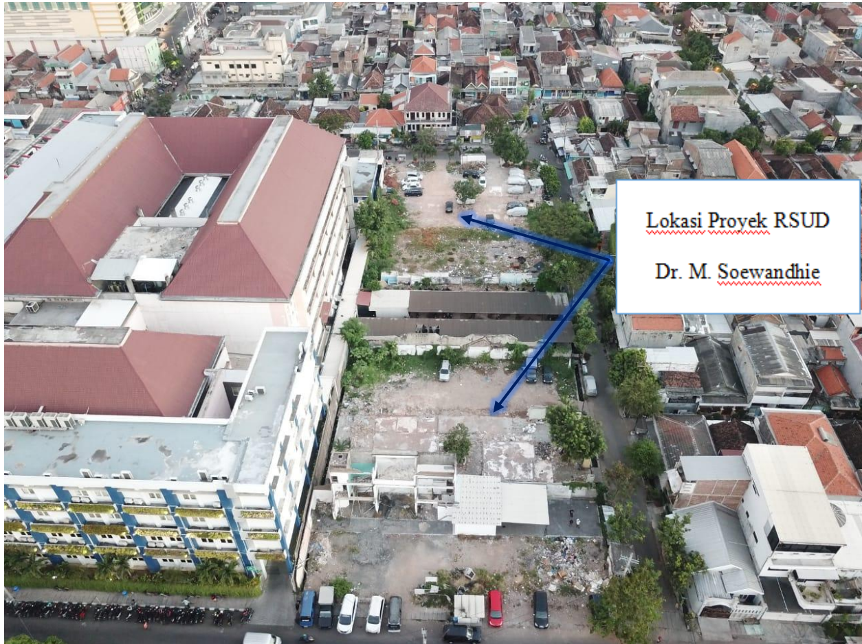
Gambar 1.1 Peta lokasi Proyek Pembangunan Gedung Type B1 RSUD Dr. M. Soewandhie Kota Surabaya (Sumber: google maps )
