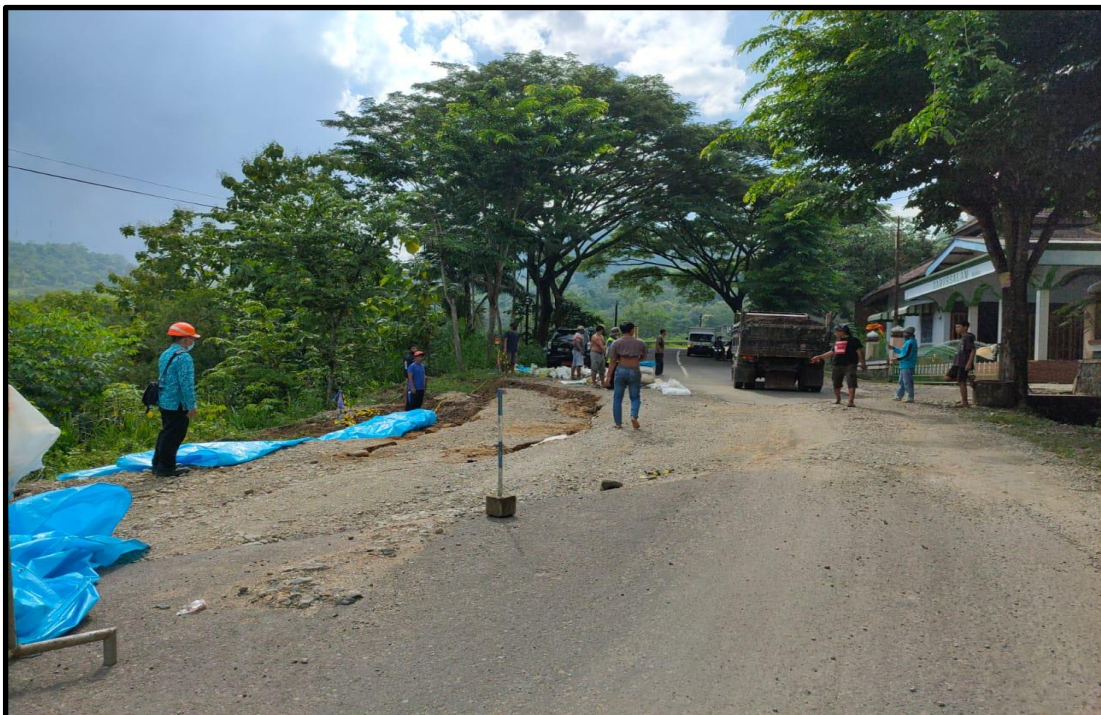
Gambar 1. 1 Keretakan Tanah Jalan Nasional Pacitan – Ponorogo
