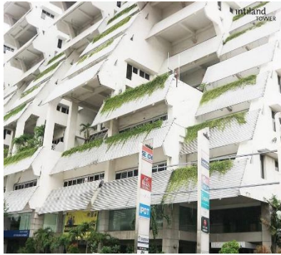
Gambar 2. 36 Balkon Intiland Surabaya
