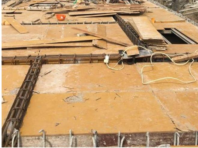
Gambar 2.13 Bekisting untuk plat lantai
