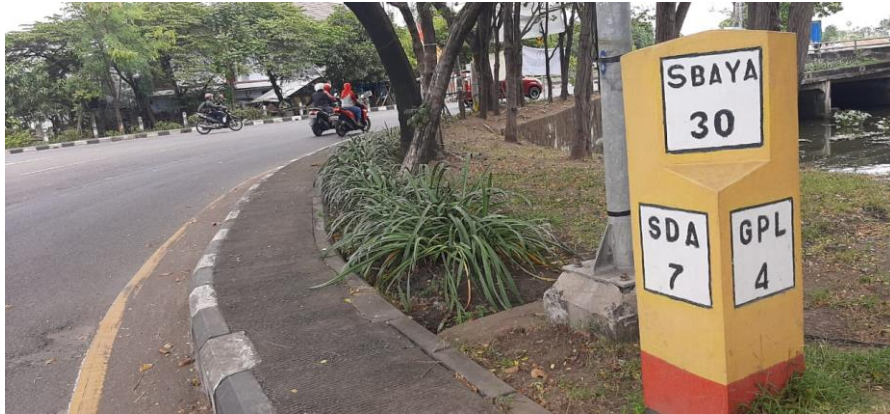
Gambar 1. 2 Titik awal daerah pantauan di jalan arteri baru Porong STA 30+00
