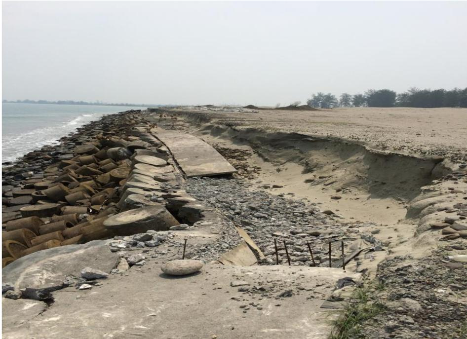
**Gambar 1.1.** Keruntuhan yang Terjadi Pada Eksisting Dinding Penahan Gelombang.
