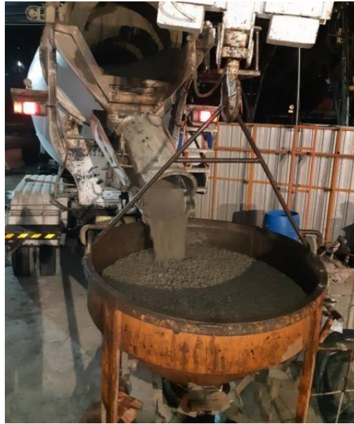
Gambar 2.12 Beton ready mix dari truck mixer ke concrete bucket
