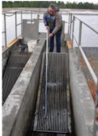
Gambar 2.3 Pembersihan Bar Screen Manual di Lapangan
