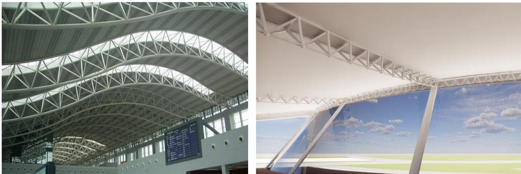
Gambar 6.6 Struktur Space Frame
