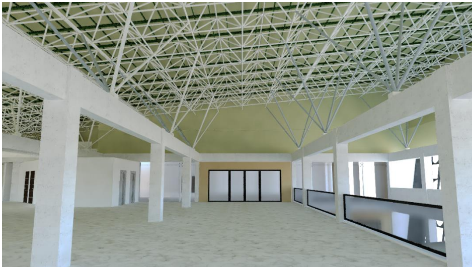
Gambar 6.13. Struktur Rangka Atap Space Frame
