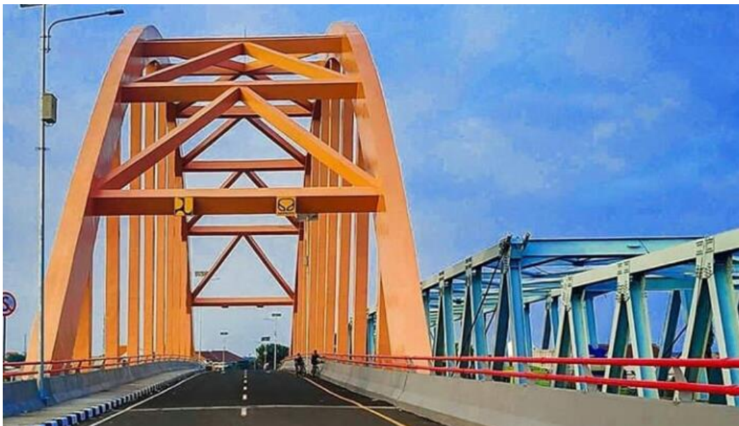
Gambar 1.2. Jembatan Eksisting Sembayat Baru II
