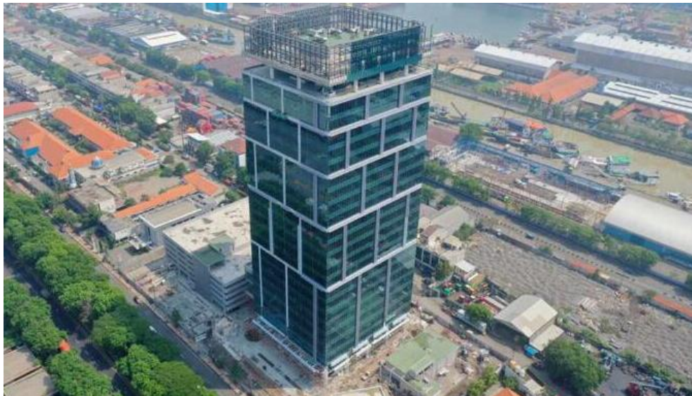
Gambar 1.1 Lokasi Proyek Pembangunan Tower Poros Maritim. Sumber:Data Sekunder.
