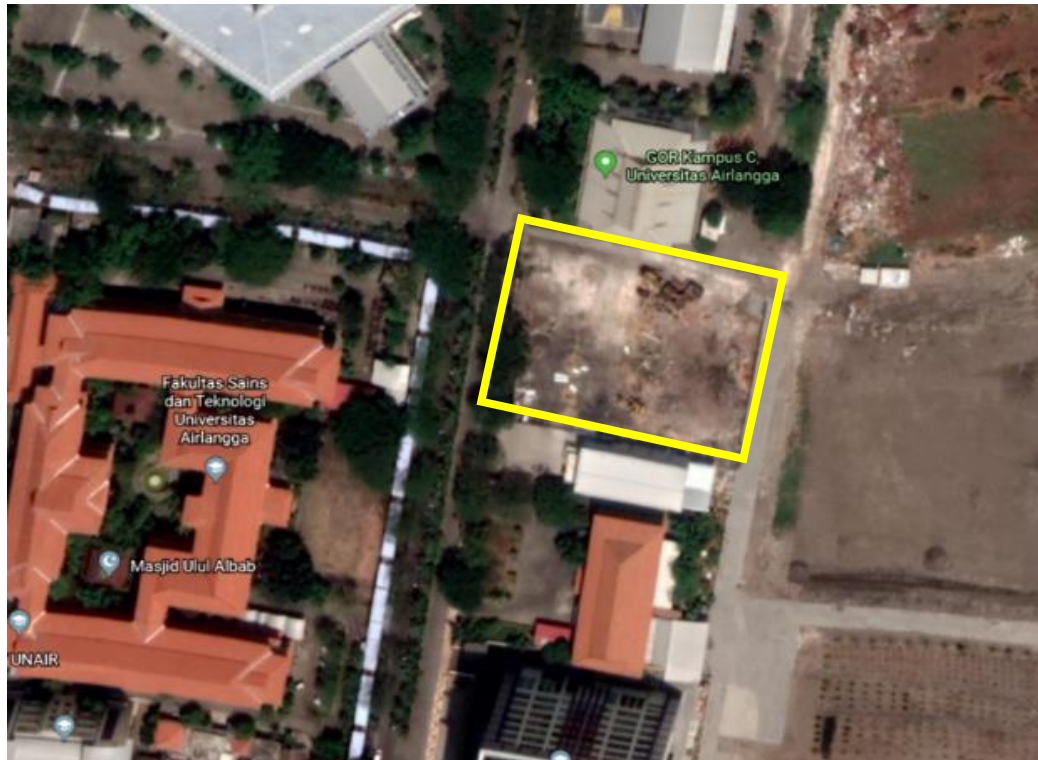
Gambar 1.1 Lokasi Gedung Kuliah Bersama Universitas Airlangga Kampus C Sumber: Google Earth
