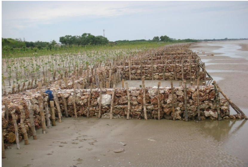
Gambar 4.6 Bangunan Trucuk di Desa Jenu Kecamatan Jenu
