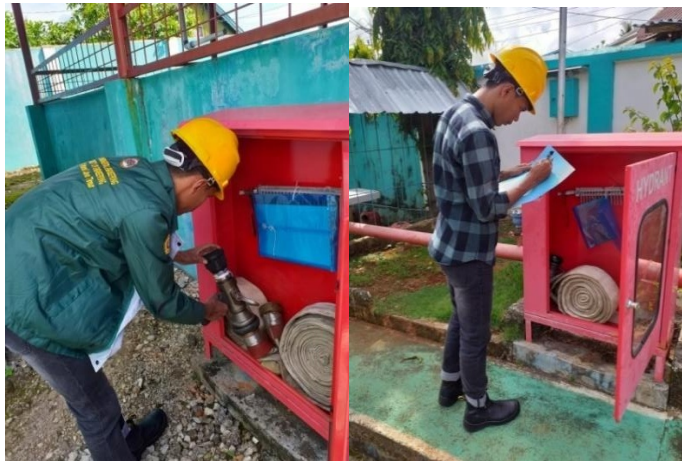
Gambar 1. Melakukan checklist Hydrant
