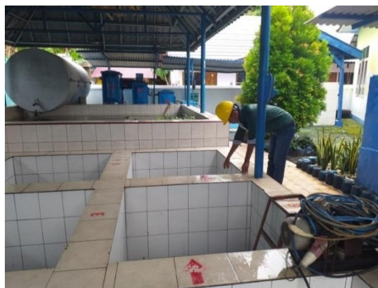
Gambar 5. Melakukan pembersihan Oil Trap
