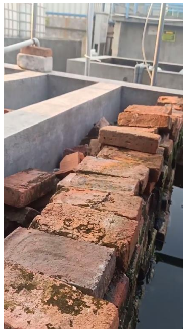
Filtrasi dengan batu bata dan pasir silica
