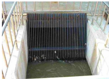
Gambar 2 . 7 Coarse Screen (Saringan Kasar)
