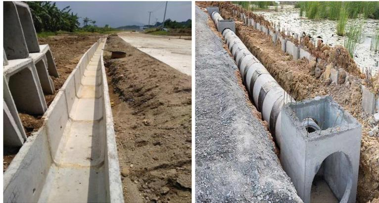
**Gambar 2.1** (a) Saluran Terbuka (b) Saluran Tertutup
