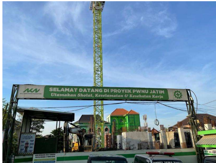
Gambar 1.2 Lokasi Proyek Tampak Depan
