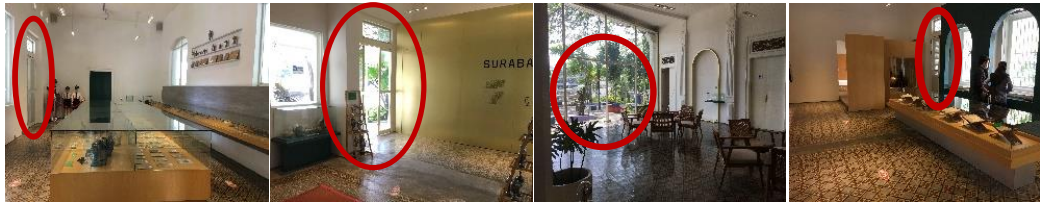
Gambar 2.13 Pintu sebagai jalur evakuasi saat terjadi kebakaran pada interior museum Sumber: Dokumen Pribadi, 2022
