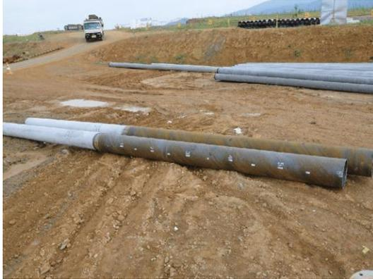
Gambar 2. 4 Tiang Komposit (*Composite Pile*)
