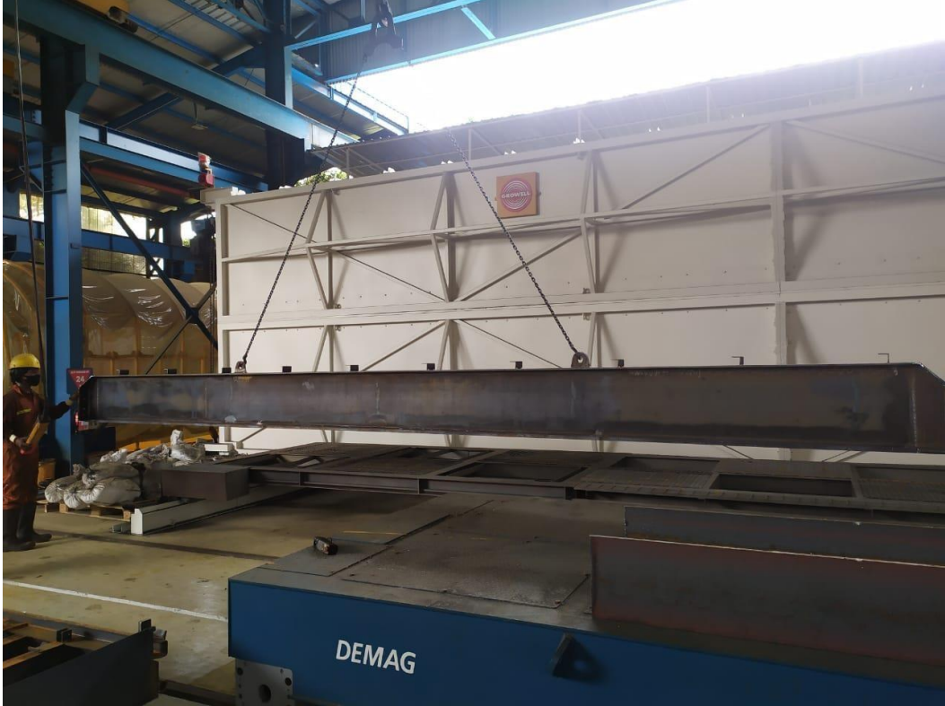
Pekerja melakukan proses sand blasting
