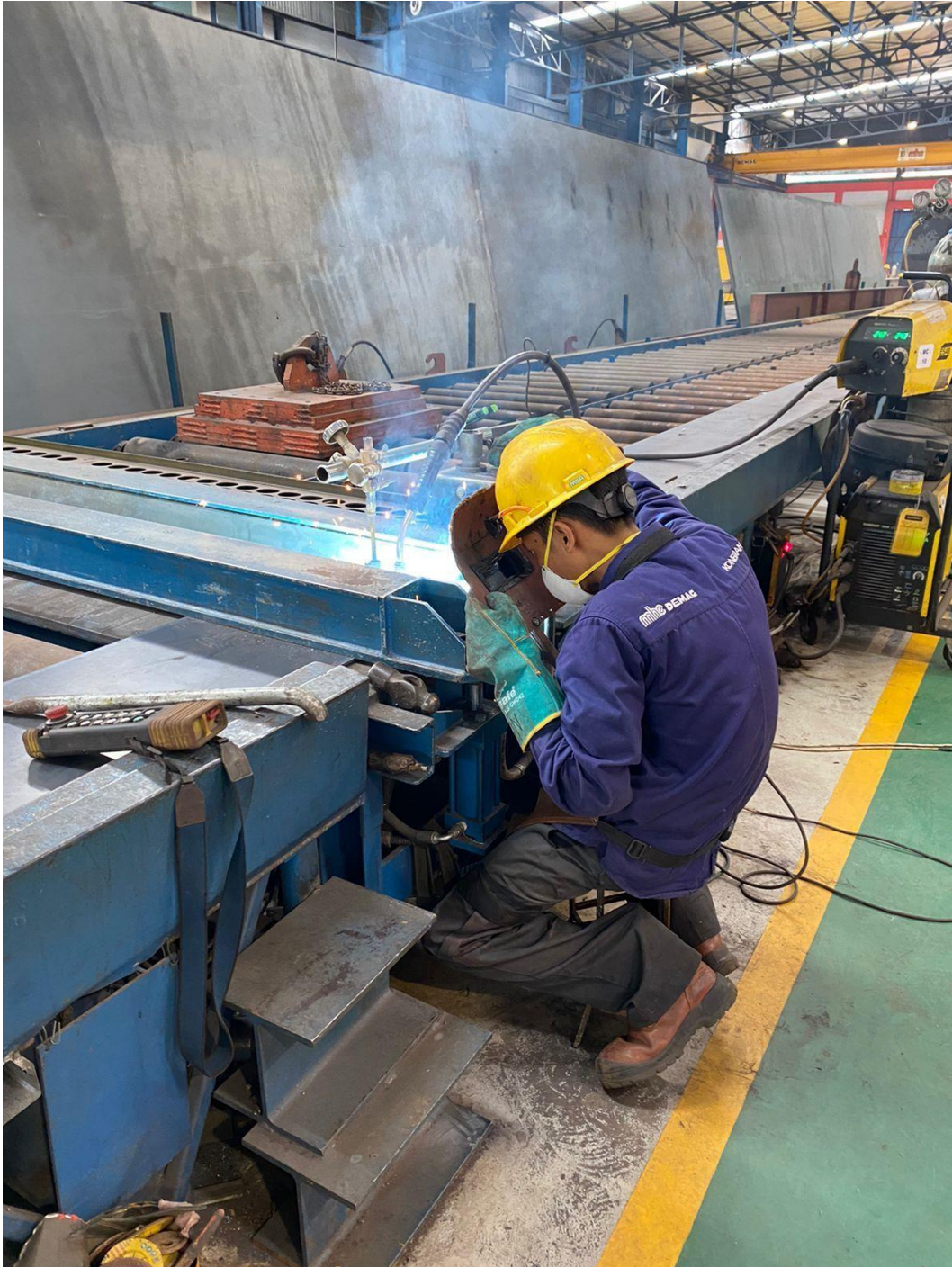
Pekerja melakukan proses Butt Welding
