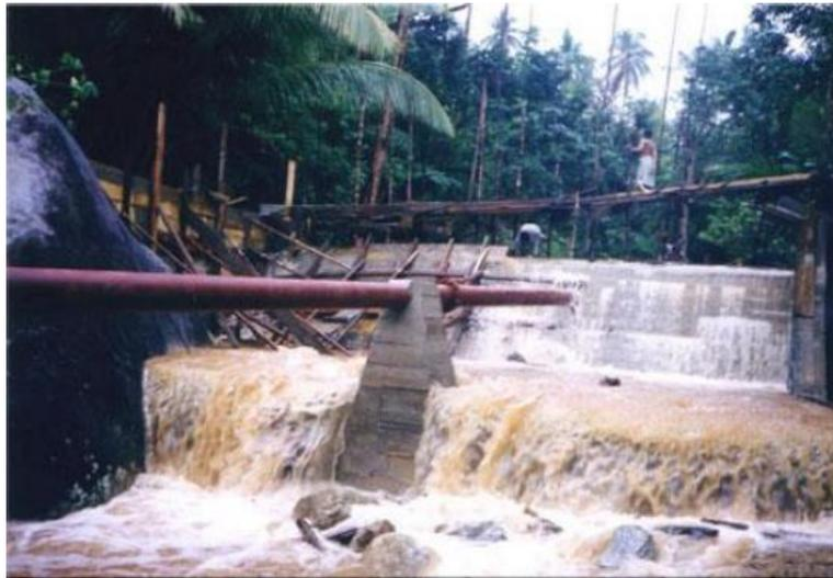
Gambar 2.4 Gambar Intake Bendung
