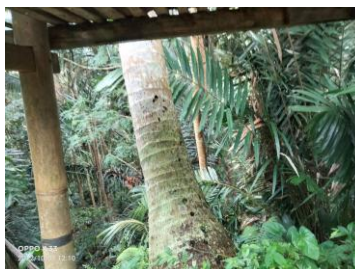
Gambar 1.4 Sekitar Agrowisata Tidak Dilengkapi Pagar Pengaman
