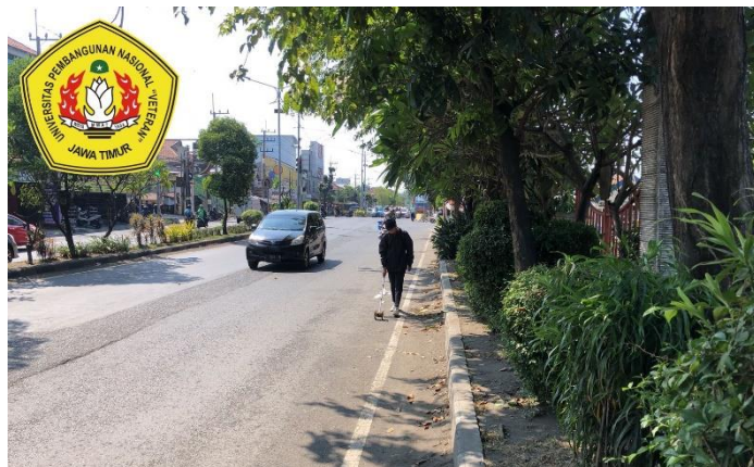
Gambar 7. Ruas Jalan Raya Tebel Buduran
