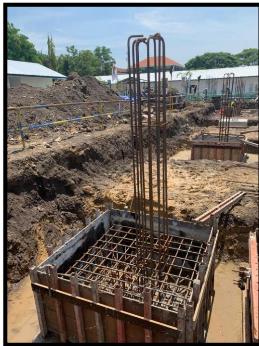
Gambar 6.1 Besi Tulangan D13 dan D16.
