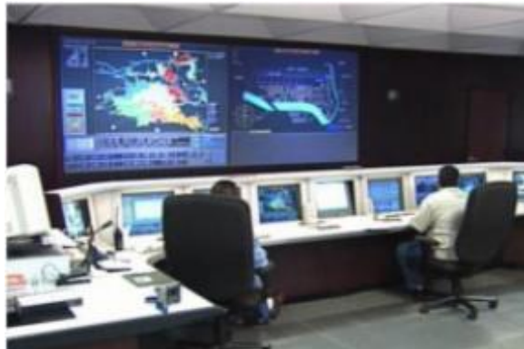
Gambar 2. 9 Master Control Room untuk mengontrol Sistem Proses Jarak Jauh
