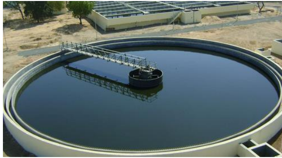
Gambar 2. 11 Bak Clarifier di Lapangan
