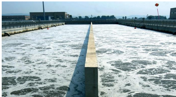
Gambar 2. 9 Lumpur Aktif Dengan Sistem Contact Stabilization
