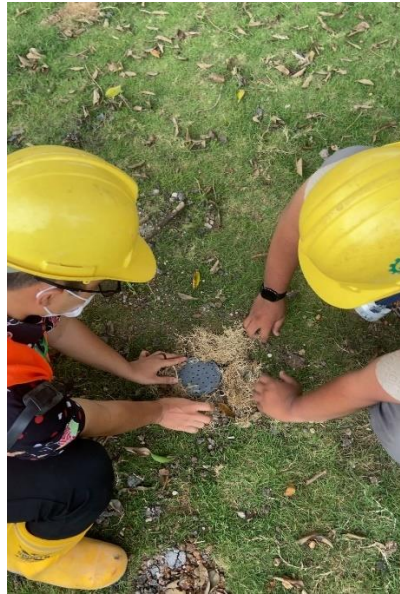
Gambar 2. 23 Pemasangan Biopori Di Salah Satu Titik Sekitar PT. Petrokimia Gresik
