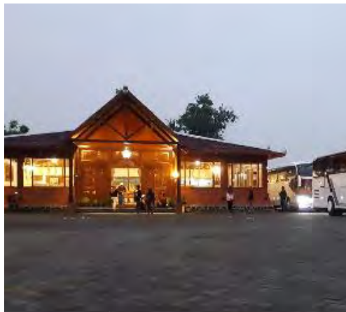
Gambar 2. 18 Bangunan Luar Bakpia Jogkem Sumber : Data Dokumentasi Bakpia Jogkem
