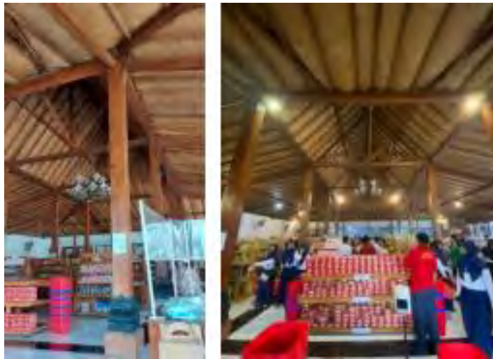
Gambar 2. 19 Stuktur saka kayu Sumber : Data Dokumentasi Pribadi
