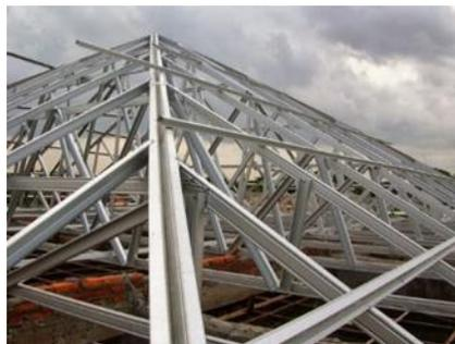
**Gambar 5. 16** Rangka Atap Baja Ringan
