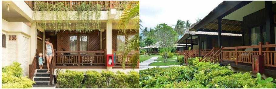
Gambar 2. 9 Struktur dan Konstruksi Bangunan Senggigi Beach Lombok Sumber: Google. 2022
